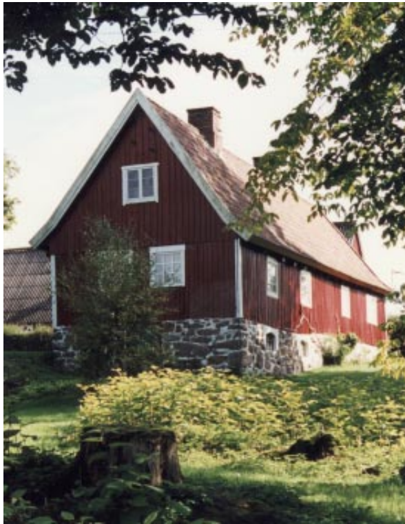
På 1940-talet kläddes många äldre hus med locklistpanel
