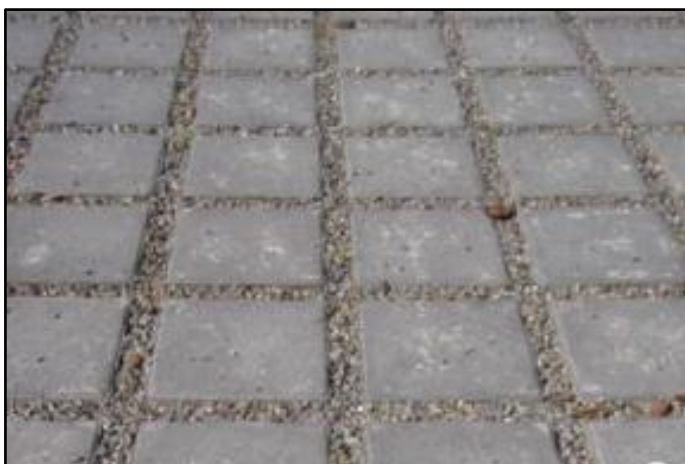
Figur 22. Exempel på genomsläpplig betongbeläggning med grusfogar.
