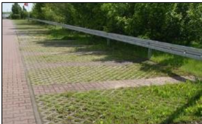
Figur 23. Exempel på genomsläpplig betongbeläggning med gräs.
