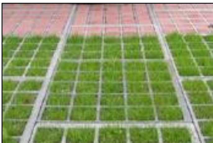
Figur 24. Exempel på genomsläpplig beläggning med gräs (alltmark.se).
