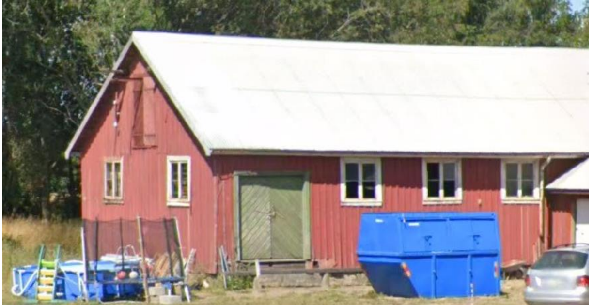
FIG 1. Foto från Google Street View visande de befintliga fönstren.
