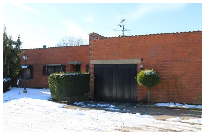
Garageport med mörkbrun stående träpanel
