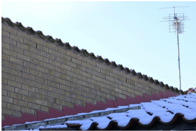
Röd plåtdetalj mellan tak och fasad
