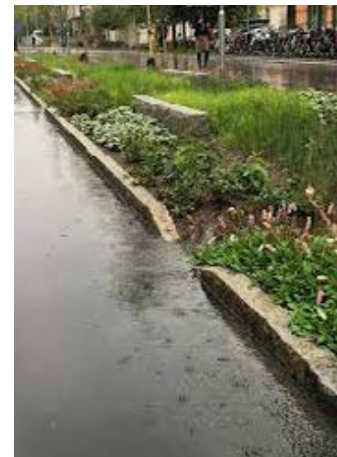
Inspirationsbild. Släpp i kantstöd för dagvattnet. Släppen behöver vara ca 50 cm långa.
